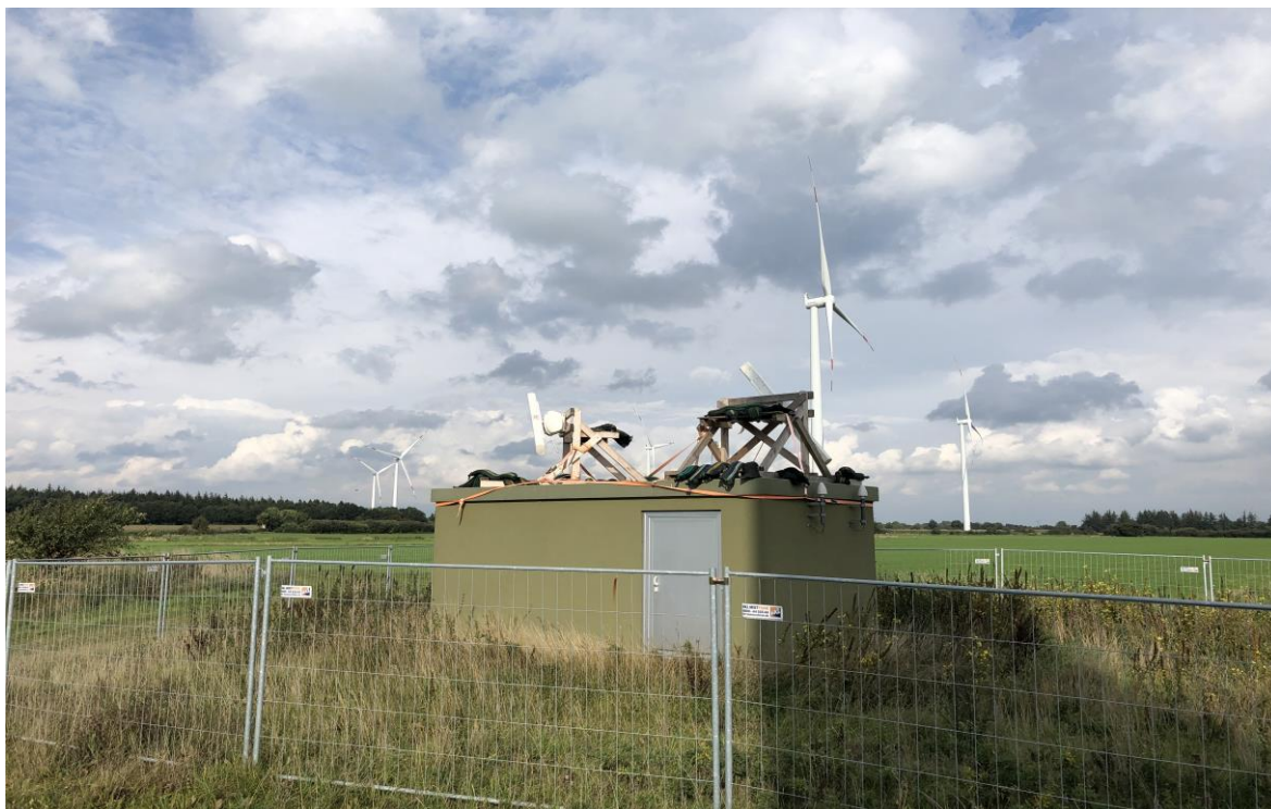
Abb. 3.4 Die beiden Holzkonstruktionen mit den Radarantennen auf dem Flachdach des Servergebudes im Burgerwindpark Holzacker-Knorburg (Quelle: Dr. Jorg Welcker, Mitarbeiter von BioConsult SH).
