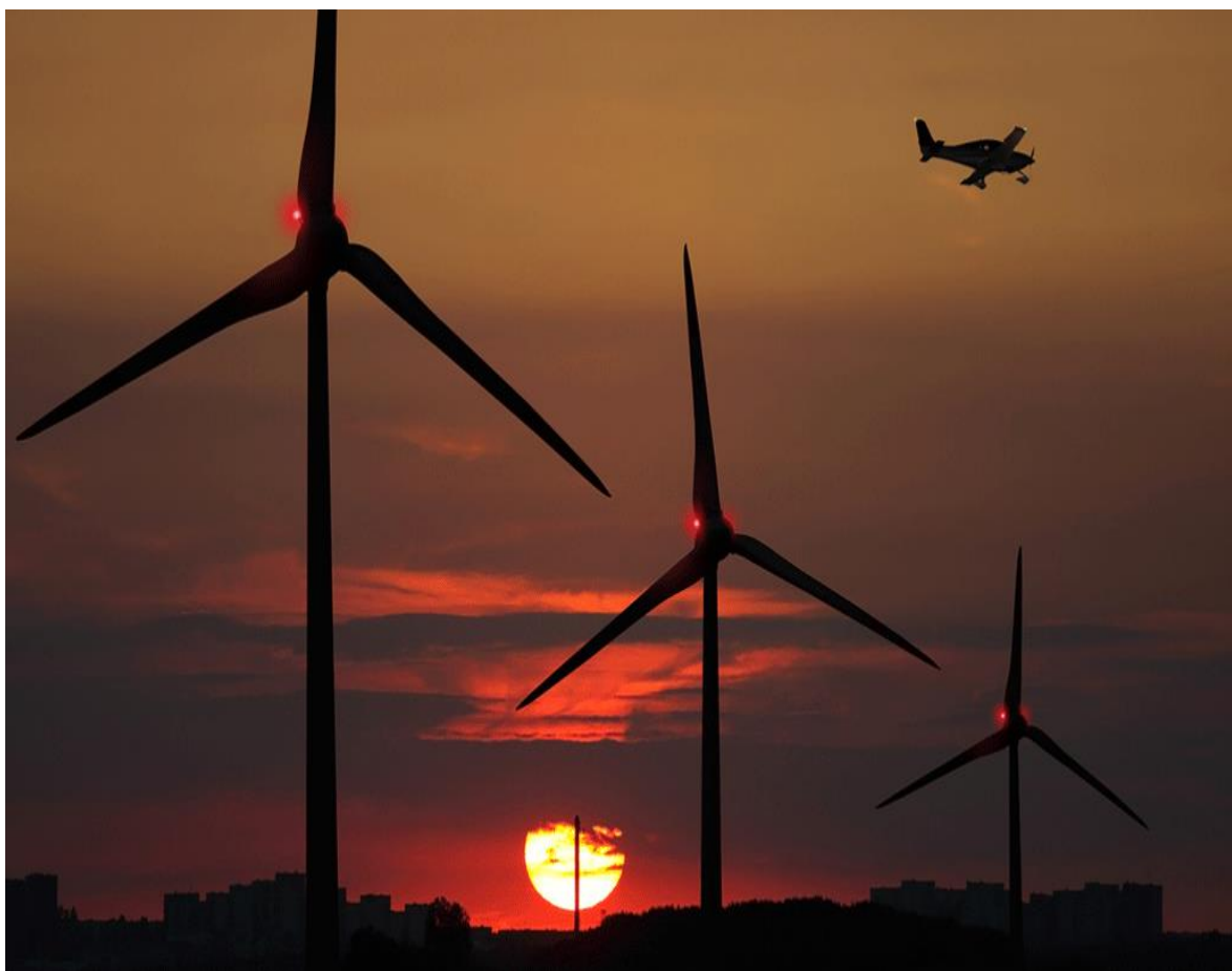
Abb. 1.1 Die BNK wird zur Gewährleistung der Flugsicherheit bei Detektion eines Flugobjektes aktiviert (Quelle: Lanthan Safe Sky GmbH, www.50komma2.de vom 19.01.2022).
