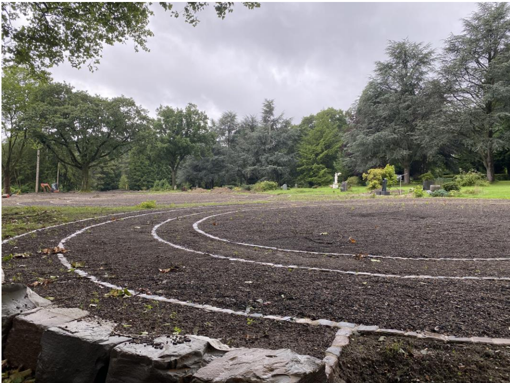
Abbildung 72: Umbauarbeiten auf dem Friedhof Hainstraße. Zuvor befand sich hier eine strukturreiche Rasenfläche. Foto: A. Umalasa, 03.08.2023
