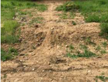
Abbildung 6.1: Offene Baggerstelle im Gebiet 1 der Königshovener Mulde am 19.05.2020, Tag 1 ab Foto, Koordinaten 51°3'6''N 6°33'9''O
