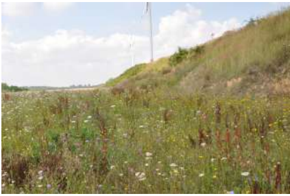
Abbildung 14: Deich des Absatzbeckens am 18.07.2020, Koordinaten 51°1'36''N 6°32'39''O
