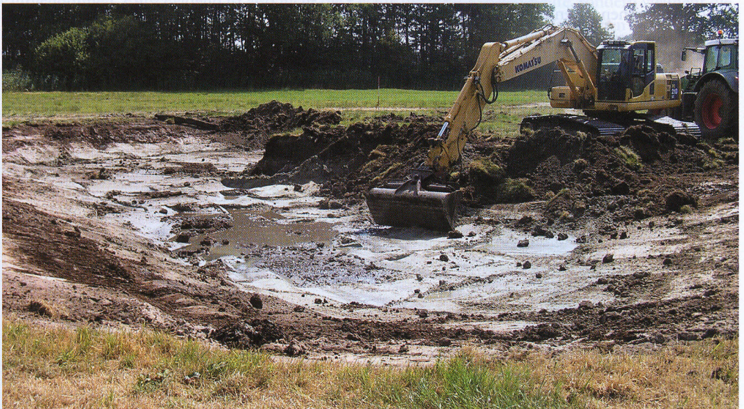
Abb. 6: Mit einem Schaufelbagger wird die dicht verfilzte Grasschicht auf einer begrenzten Fläche abgetragen. Dadurch werden offene Böden freigelegt, die sich in der Sonne schnell erwärmen. Zusätzlich werden kleine Abbruchkanten geschaffen, an denen sich Wildbienen ansiedeln können (Fotos: Michael Weinert, Artland/ Kreis Osnabrück im Jahre 2018).
